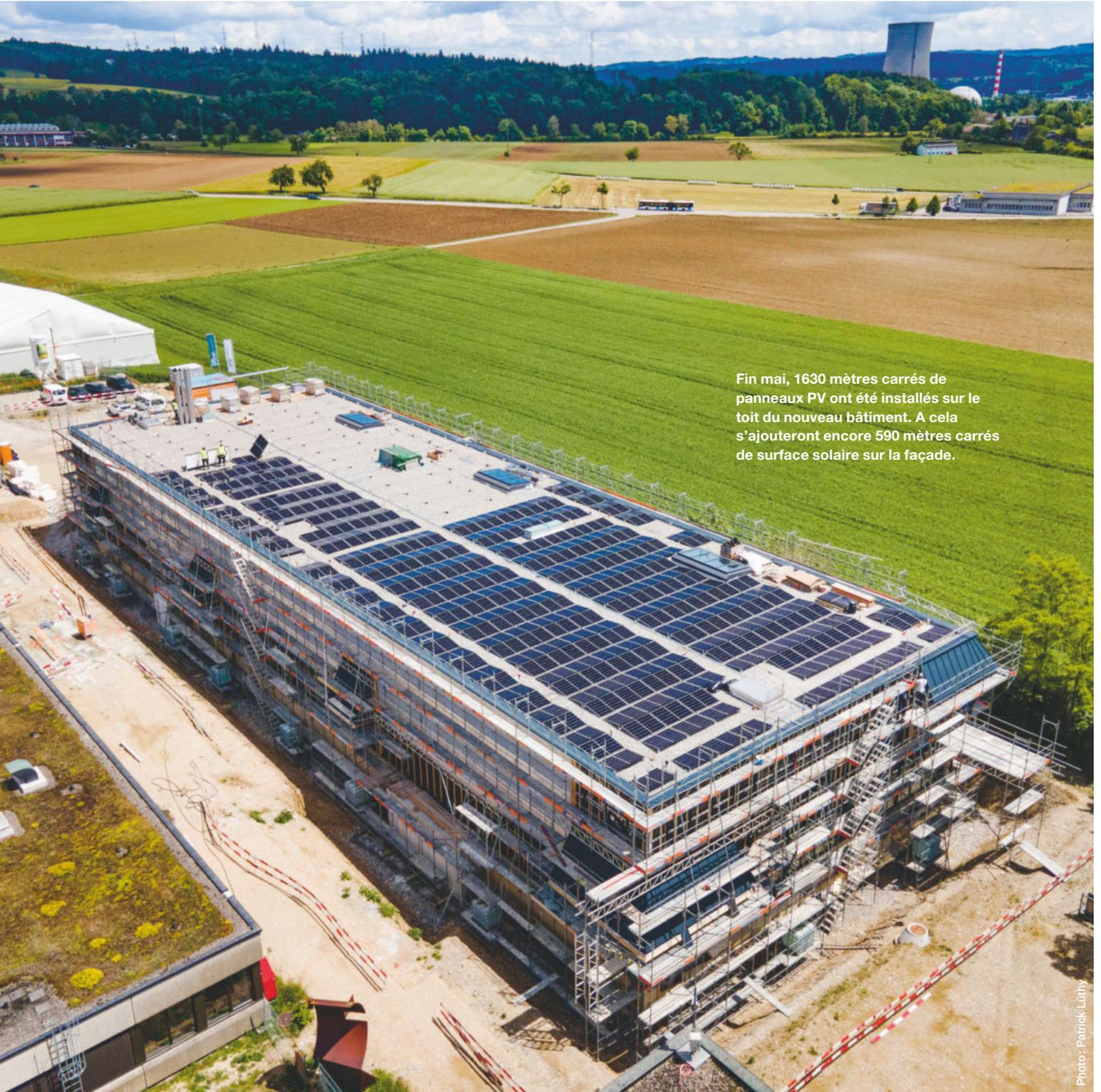
Fin mai, 1630 mètres carrés de panneaux PV ont été installés sur le toit du nouveau bâtiment. A cela s'ajouteront encore 590 mètres carrés de surface solaire sur la façade.
